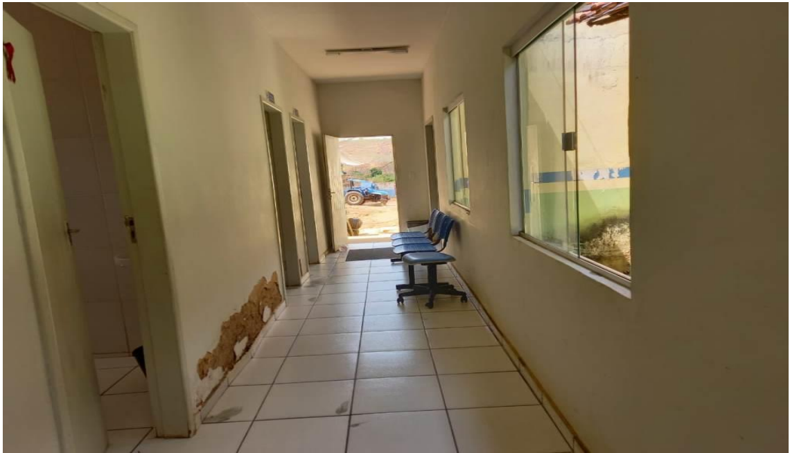
8 - FOTO – SALA DE EMERGÊNCIA – (SUBSTITUIR PISO/SUBSTITUIR RODAPÉ/PINTURA GERAL).
