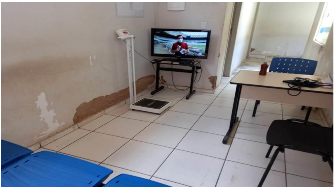
4 - FOTO – RECEPÇÃO BLOCO 02 – (RECUPERAR REBOCO DO TETO E PAREDES/PINTURA GERAL).
