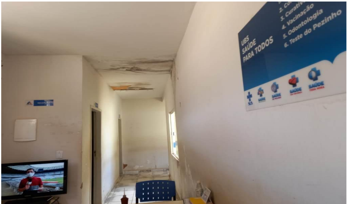
4 - FOTO – RECEPÇÃO BLOCO 02 – (RECUPERAR REBOCO DO TETO E PAREDES/PINTURA GERAL).
