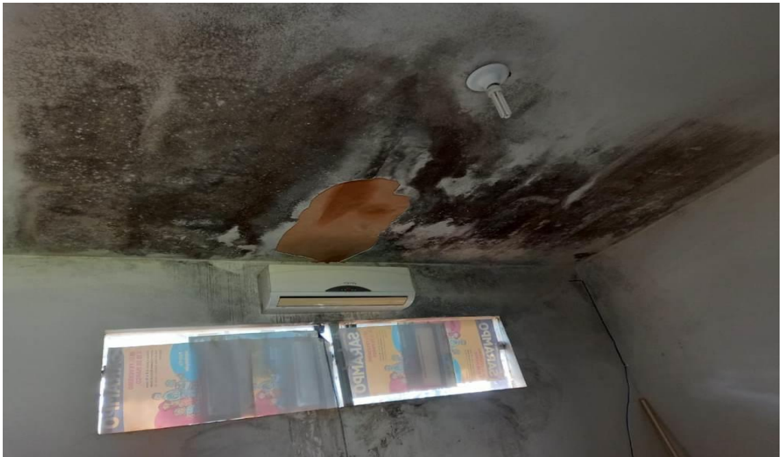
6 - FOTO – SALA DE ATENDIMENTO - ( RECUPERAÇÃO DE REBOCO TETO/PINTURA GERAL).
