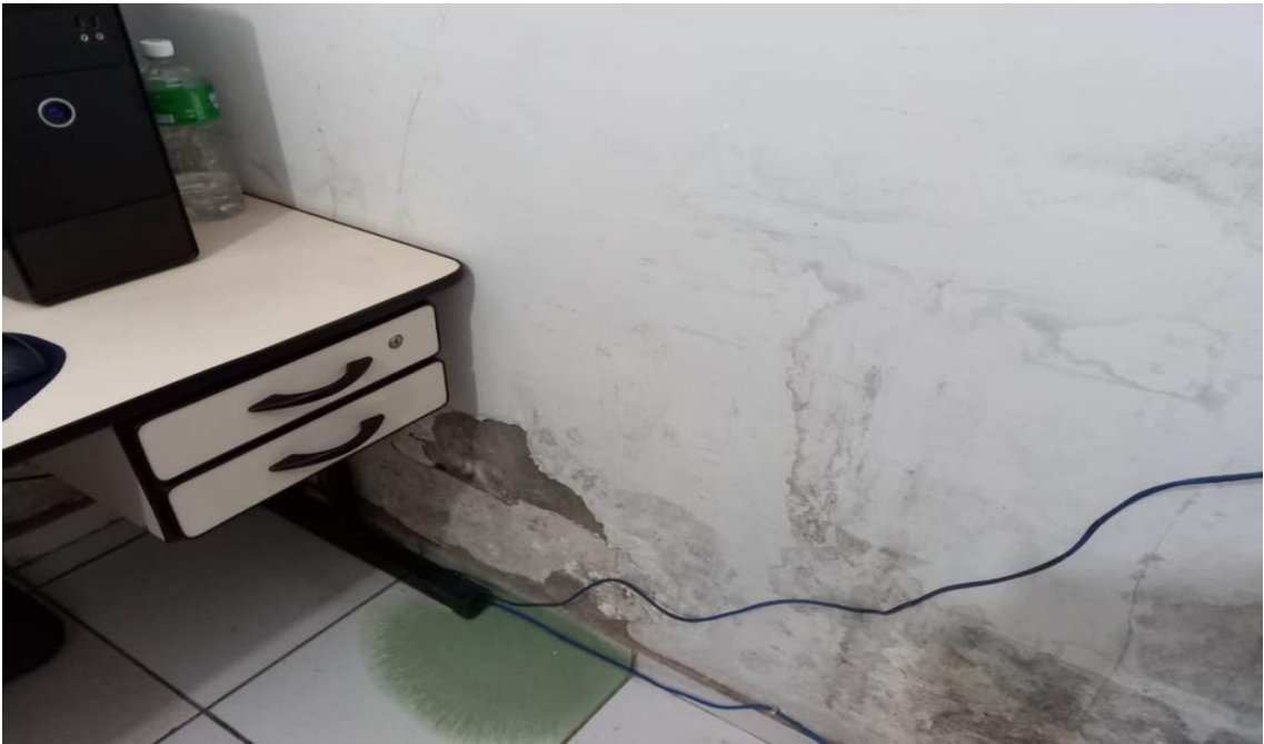
12 - FOTO – SALA DE NEBULIZAÇÃO – (RECUPERAR REBOCO/PINTURA GERAL).
