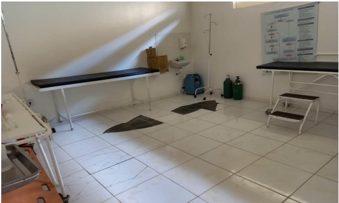
8 - FOTO – SALA DE EMERGÊNCIA – (SUBSTITUIR PISO/SUBSTITUIR RODAPÉ/PINTURA GERAL).
