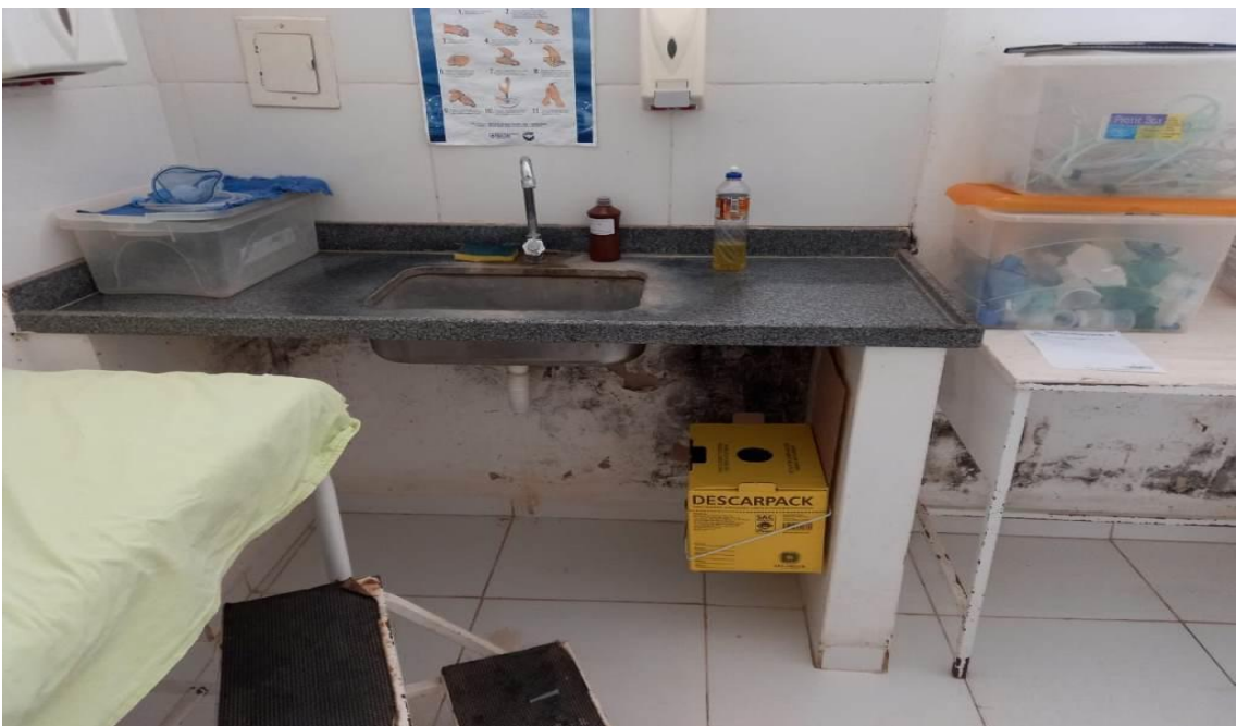
12 - FOTO – SALA DE NEBULIZAÇÃO – (RECUPERAR REBOCO/PINTURA GERAL).
