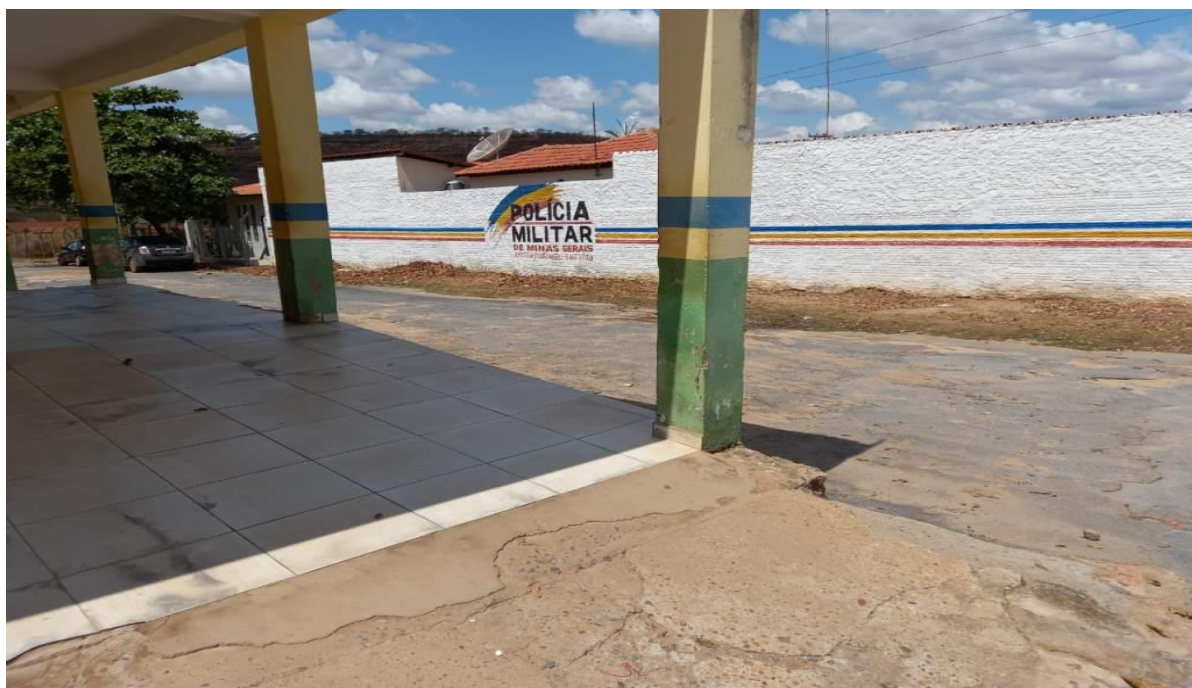
FOTO 02 - EMBARQUE/DESEMBARQUE – (INSTALAR GUARDA-CORPO E CORRIMÃO, FAZER PINTURA GERAL).
