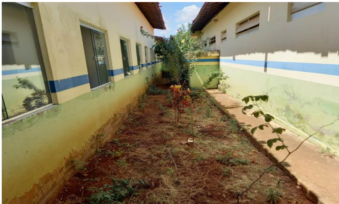
FOTO 06 - ATENDIMENTO PSICOLÓGICO – (RECUPERAR REBOCO, IMPERMEABILIZAR E FAZER PINTURA GERAL).
