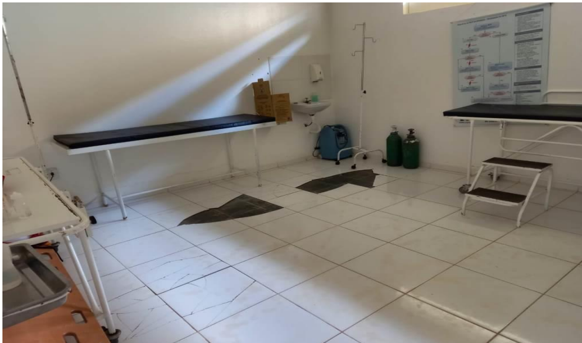
FOTO 12 - CORREDOR ACESSO BLOCO 01 – (SUBSTITUIR PISO, RECUPERAR REBOCO E FAZER PINTURA GERAL).
