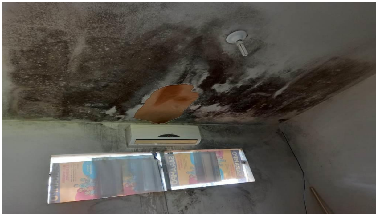
FOTO 08 - CORREDOR CIRCULAÇÃO BLOCO 02 – (RECUPERAR REBOCO, IMPERMEABILIZAR E FAZER PINTURA GERAL).
