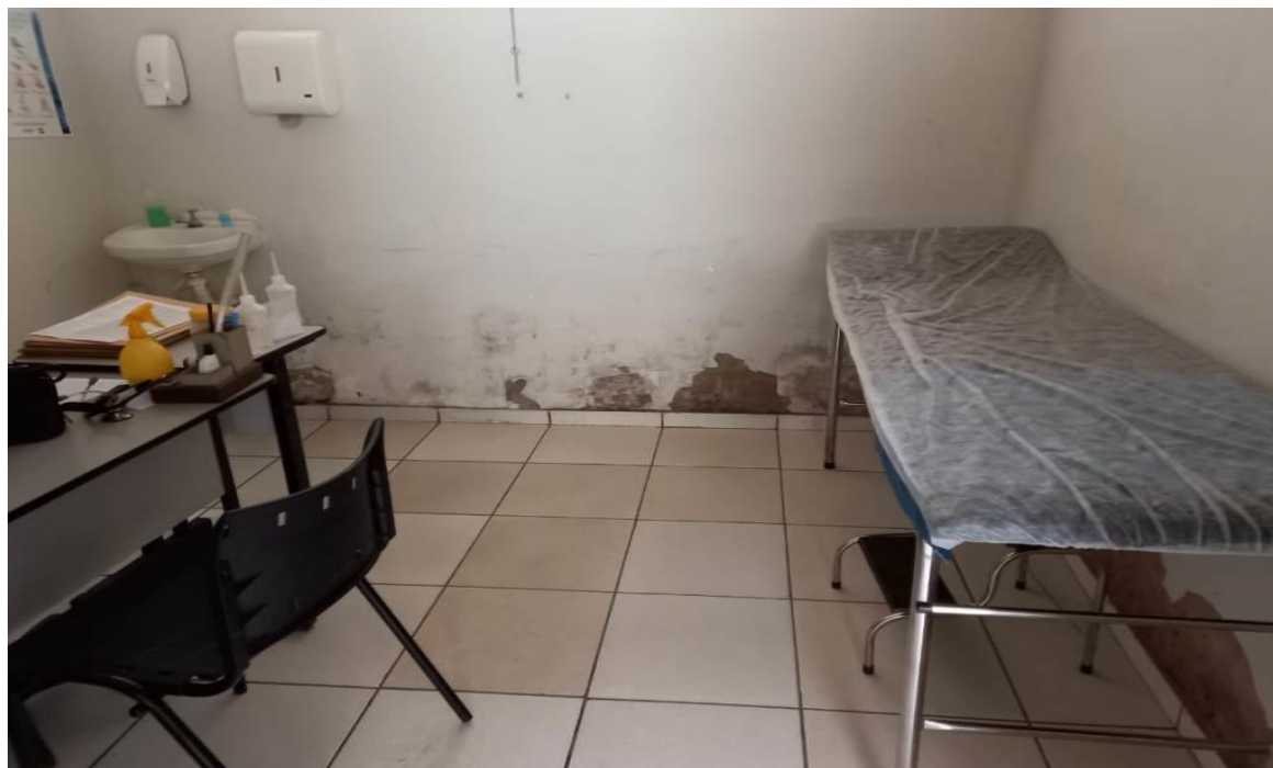
FOTO 06 - ATENDIMENTO PSICOLÓGICO – (RECUPERAR REBOCO, IMPERMEABILIZAR E FAZER PINTURA GERAL).
