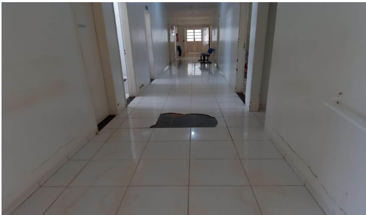
FOTO 12 - CORREDOR ACESSO BLOCO 01 – (SUBSTITUIR PISO, RECUPERAR REBOCO E FAZER PINTURA GERAL).
