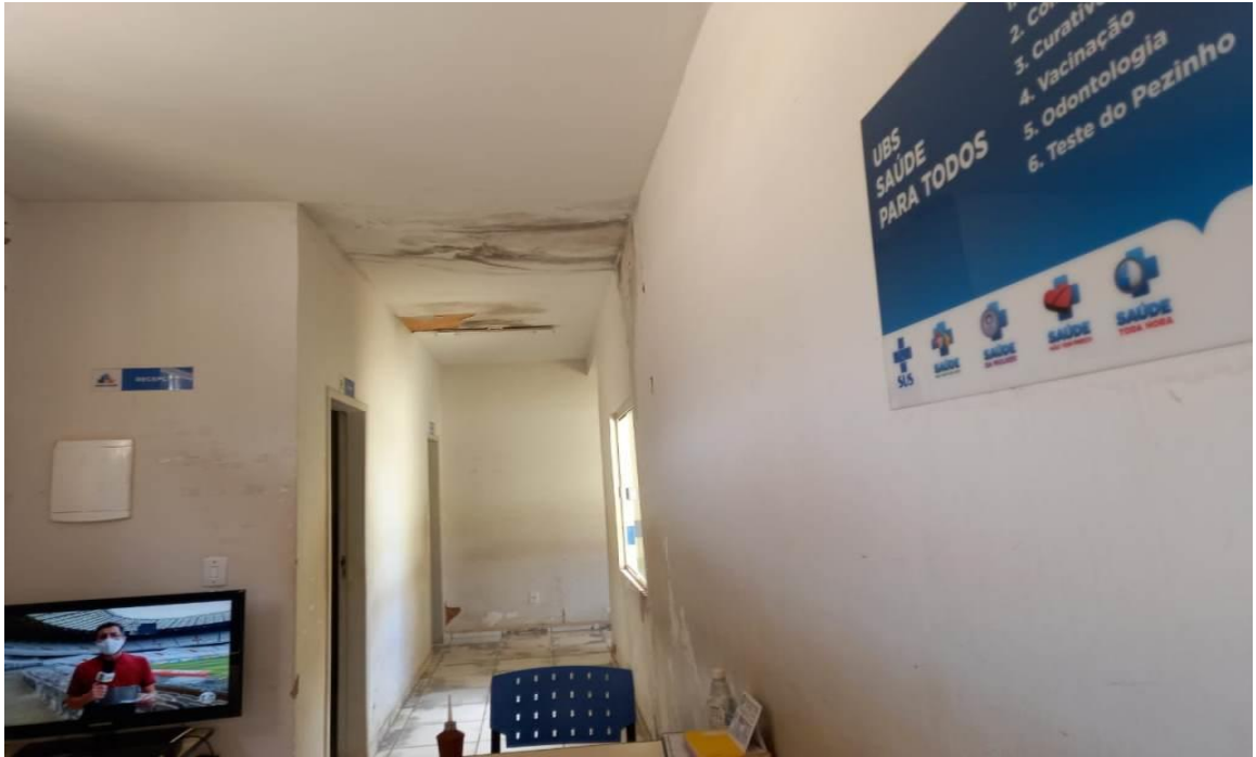
FOTO 04 - SALA DE ESPERA BLOCO 02 – (RECUPERAR REBOCO E FAZER PINTURA GERAL).
