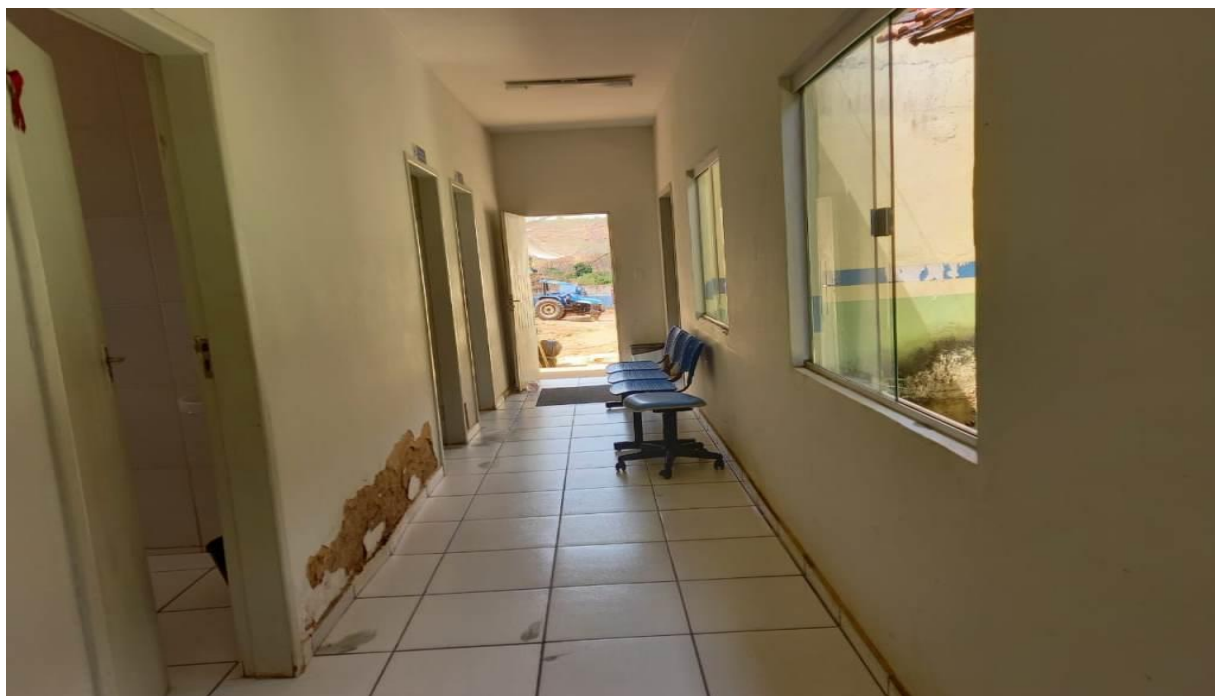
FOTO 08 - CORREDOR CIRCULAÇÃO BLOCO 02 – (RECUPERAR REBOCO, IMPERMEABILIZAR E FAZER PINTURA GERAL).
