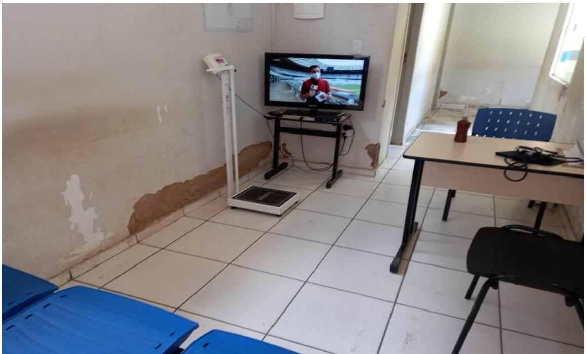
FOTO 04 - SALA DE ESPERA BLOCO 02 – (RECUPERAR REBOCO E FAZER PINTURA GERAL).
